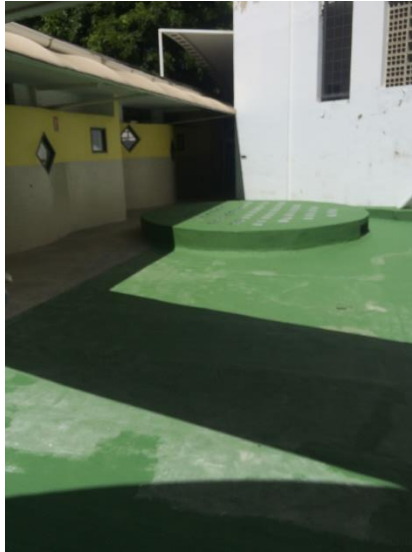
Trabajos en proceso – Impermeabilización del techo de cantina
