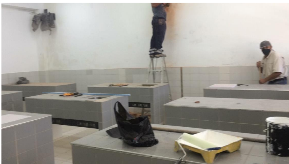
Remodelación de laboratorios – Edificio Bachillerato francés
