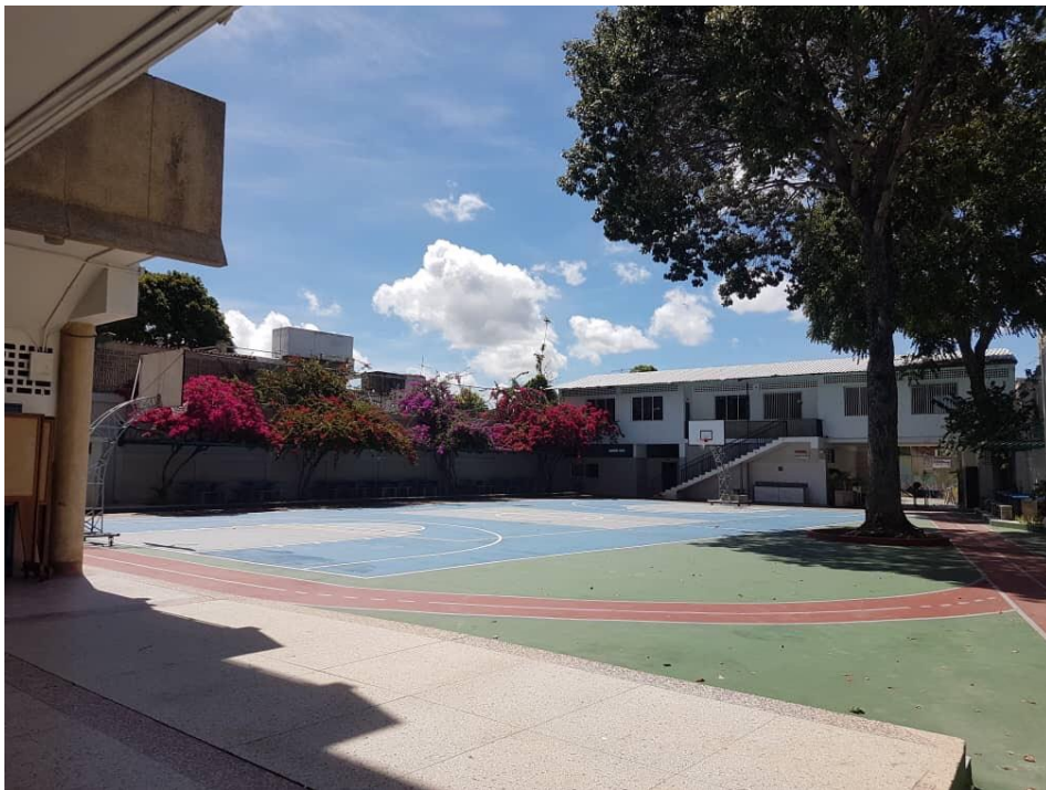
Trabajos en la cancha sur – Bachillerato francés
