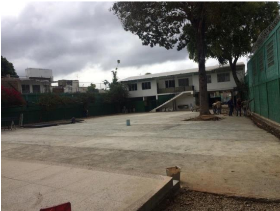
Trabajos en la cancha sur – Bachillerato francés
