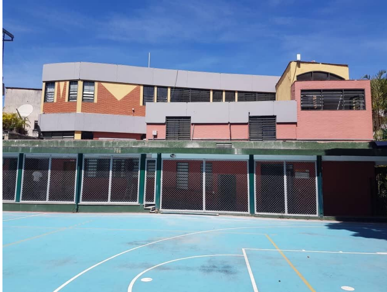
Trabajo en techo pasillo edificio Sala Polivalente
